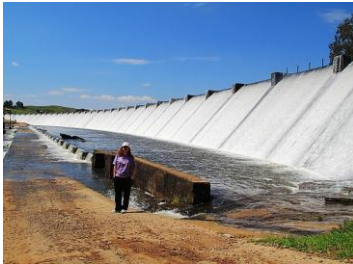
Barragem do Salto
